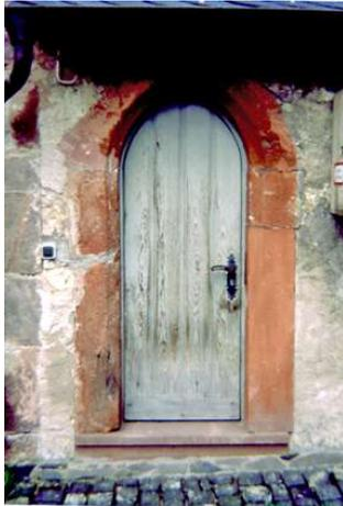
Aber als man eine Heizung in die Kirche einbaut, erweitert man diesen Raum nach Süden und bringt ihn in eine Flucht mit der Kirchenwand. Der alte Türbogen wird dabei wieder verwendet und in die neue Wand eingesetzt. Das Tor besitzt an der Außenseite abgeschrägte Kanten mit einem Übergang zum Sockel in Form einer Halbpyramide aus zwei spitzwinkligen Dreiecken.
